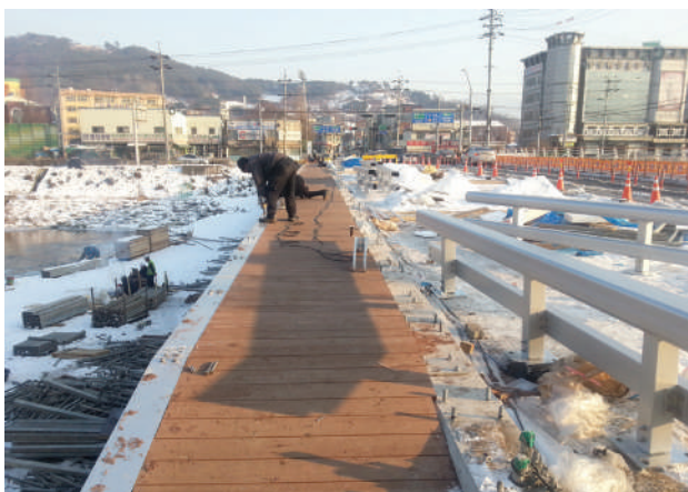
5. 난간 및 방호책 시공
