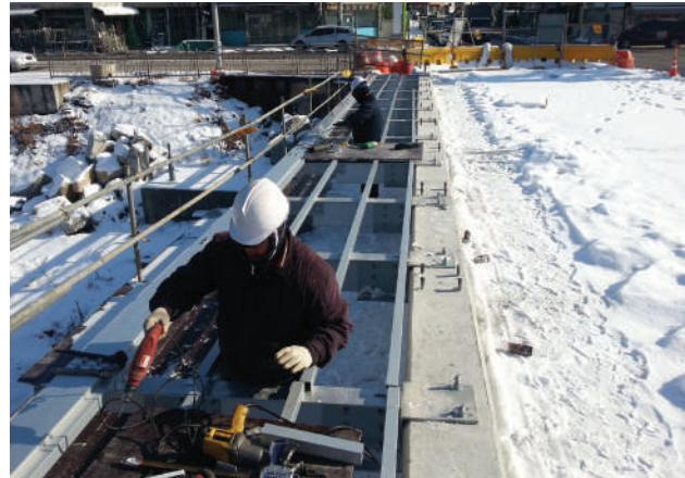
2. 브라켓 및 하지 장선 거치작업
