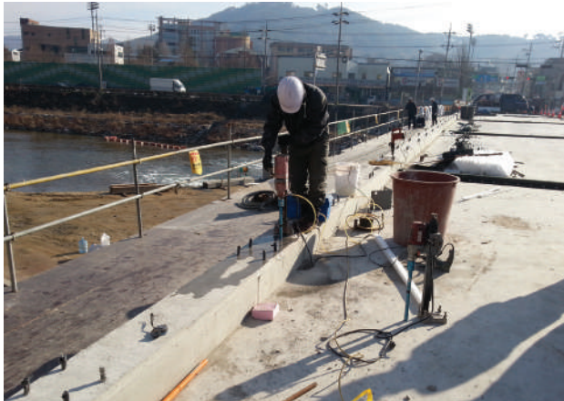
1. 코아 천공 작업
