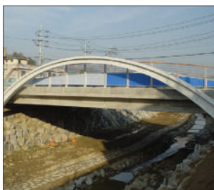
파주시 분수천 개수공사
