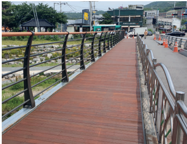
●인도교 설치 후(인도 확보를 통한 안전 보행)
