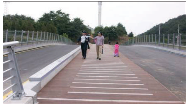
■ 난지공원 평화,중앙 브릿지 데크 설치공사
