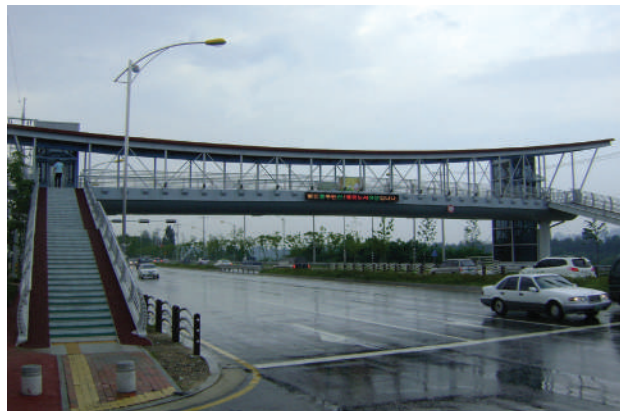
■ 하남시 조정호간육교 경관 캐노피 설치공사
