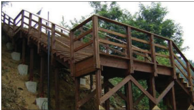
■ 난지공원 목재 계단 설치공사
