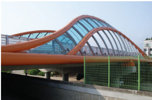
■ 화성시 발안천교 조형물 설치공사
