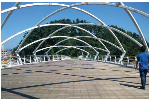
■ 강릉시 안목항 조형물 설치공사
