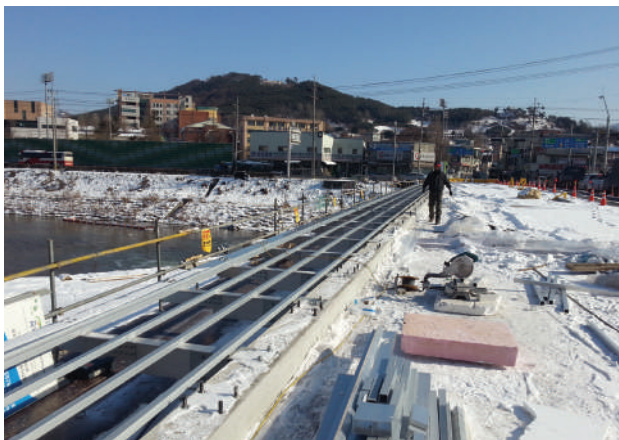
3. 하지 작업 완료
