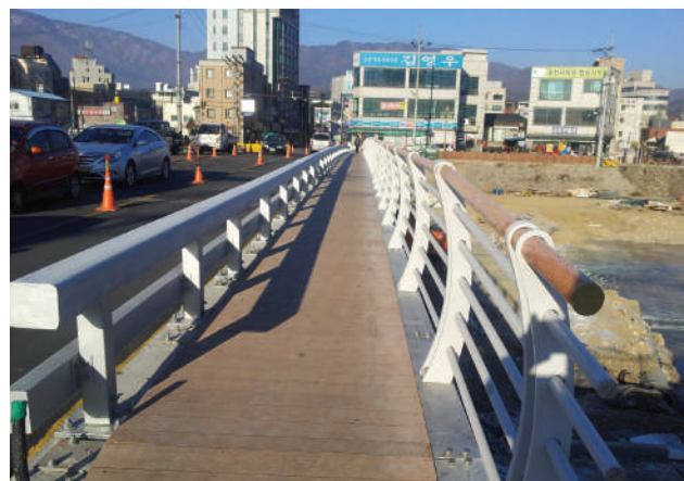
6. 시공 완료 후 개통
