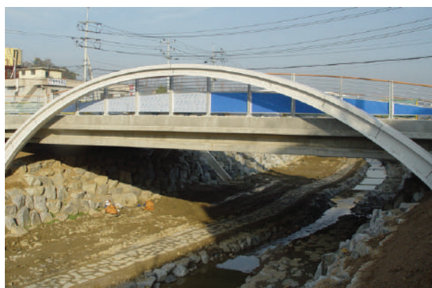
■ 파주 분수천 교량 조형물 설치공사
